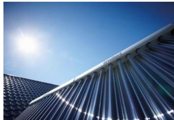
Ukoliko sunčev zračenje nije dovoljno za zagrijavanje vode, uključit će se dogrijavanje konvencionalnim sistemom grijanja do zadane temperature.
